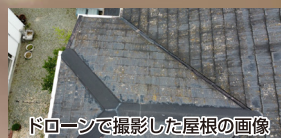
ドローンで撮影した屋根の画像
